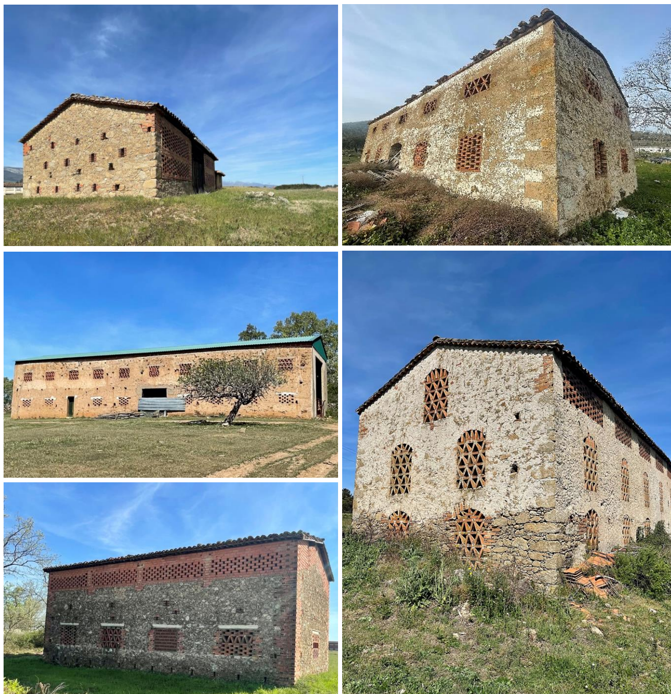
Fig.4.12 Primeros lugares de secado de piedra con celosía de ladrillo. (De izq. a drcha. y de arriba a abajo): Secadero en Villanueva de la Vera (32), Pasarón de la Vera (33), Tejada de Tiétar (34), Valverde de la Vera (35) y Villanueva de la Vera (36) (2020-2023) por la autora.
