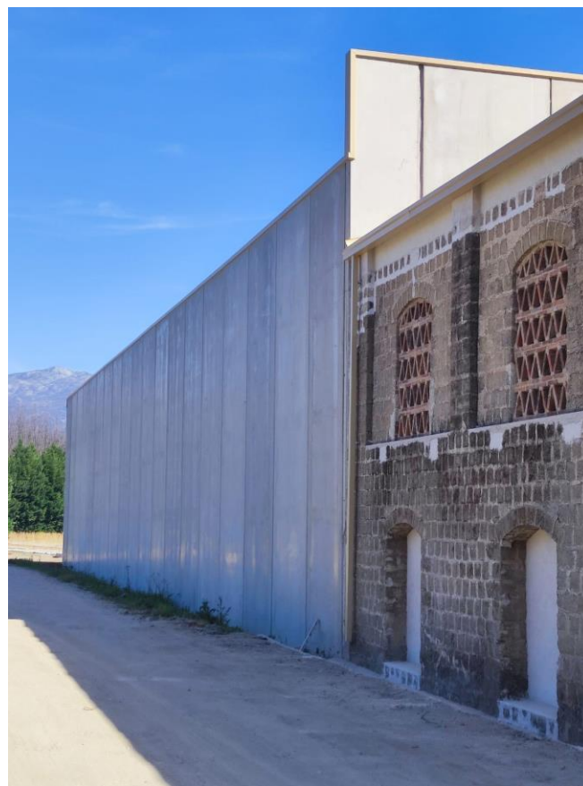
Fig.5.3 Destrucción de la identidad del secadero de las Lomas (el mismo que el de la portada del capítulo 5) por una rehabilitación sin directrices ODS (2023) por la autora.
